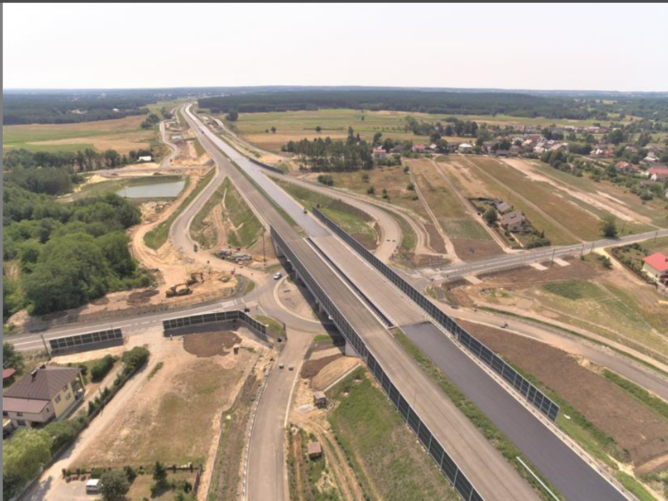
S 19 – odcinek Podgórze - Kamień
