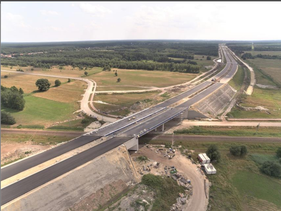
S 19 – odcinek Nisko - Podgórze
