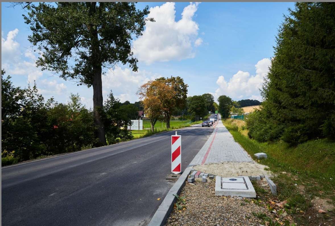
Przebudowa drogi krajowej nr 28 na odc. Siepietnica-Trzcinica
